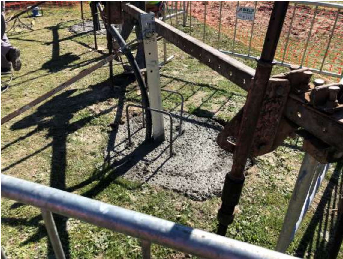
Betonfundamente für die Masten
