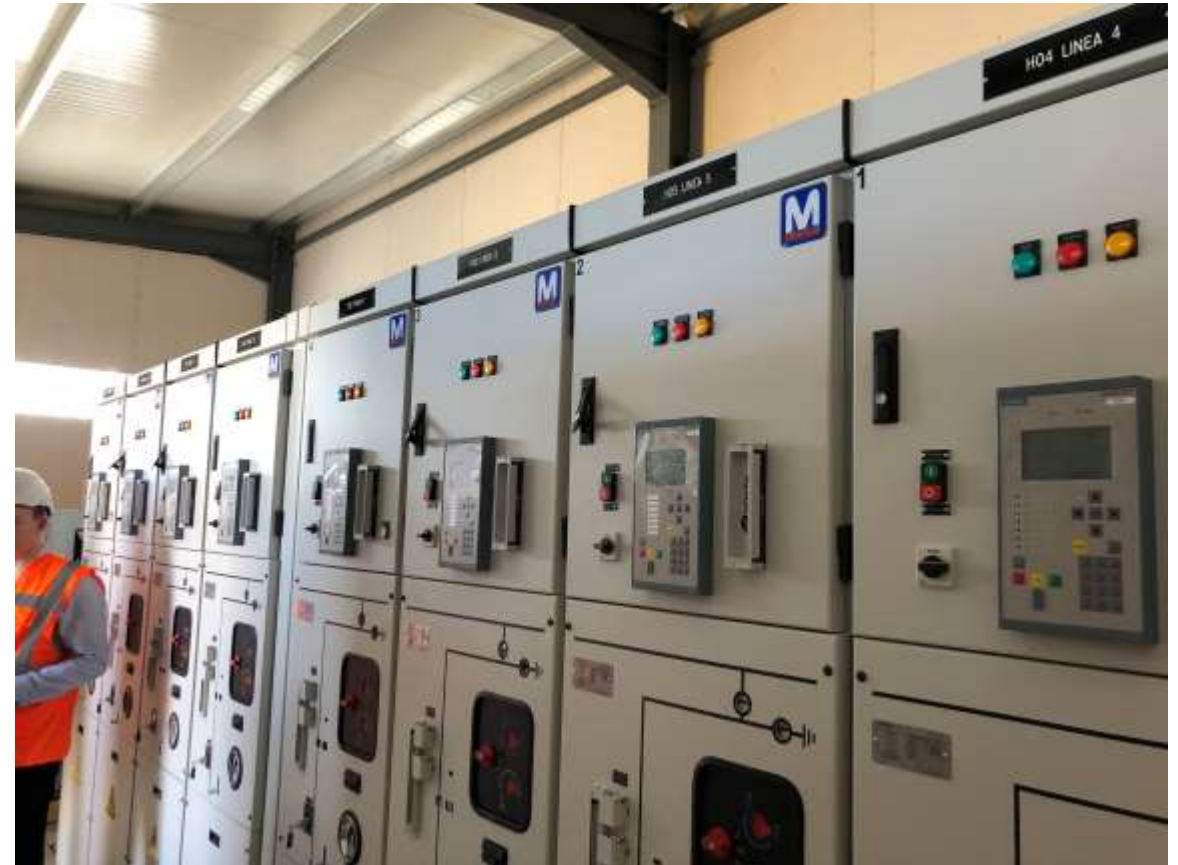
Mittelspannungs-Schaltschränke
